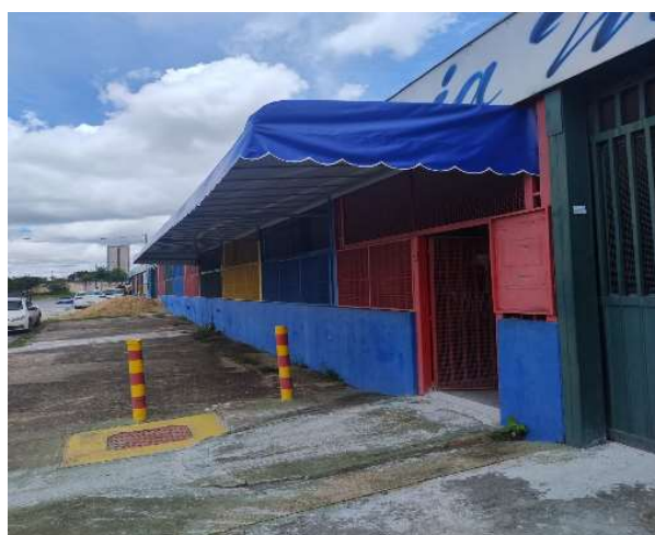
Instalação da janela na cozinha e toldo na área externa
